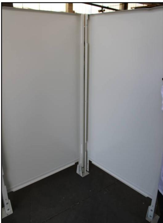
4) Se nel layout c'è un angolo, è consigliabile partire da quel punto, così che il montaggio risulterà molto più sicuro e stabile.
