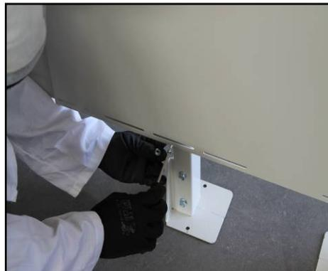
1) Fissare la parte superiore del pannello universale ai pannelli standard.
